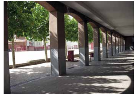
Vista del patio aporticado.
