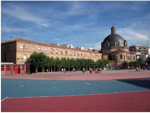
El patio en la actualidad y al fondo el edificio de Primaria y la Iglesia.
