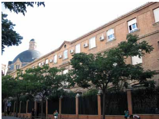
Fachada principal del colegio.
